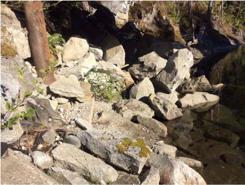
Eroded riprap
